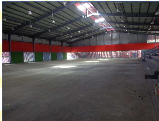
Vista interna de las instalaciones del Gimnasio de Combate donde se aprecia construcción de losa de concreto reforzado y reemplazo de la cubierta de techo.
