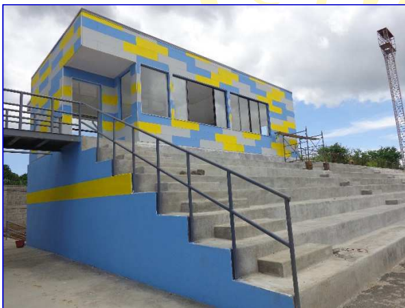
Área de certificación, donde se observa la ejecución de las actividades de ventanas, cielo falso y pintura.
